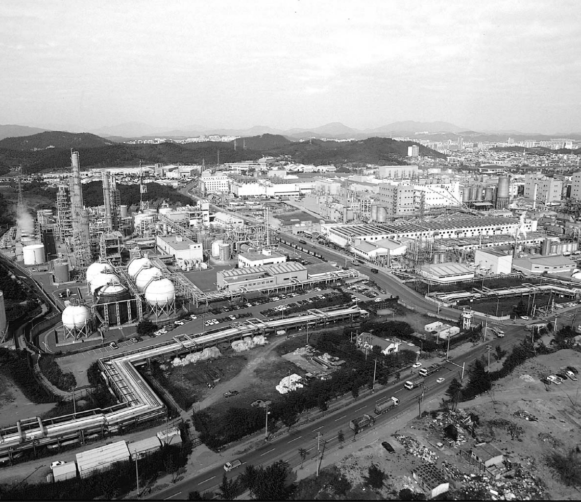
일주는 고회를 넘긴 나이에도 열정적인 추진력으로 석유화학공장 건설에 매진했다. 1994년 석유화학 제1공장 착공을 시작으로 3년 동안 제3공장, 제2공장을 완공하며 화석원료인 PTA, AN, 프로필렌 생산체제를 갖추었다. 사진은 울산 석유화학공장 전경
