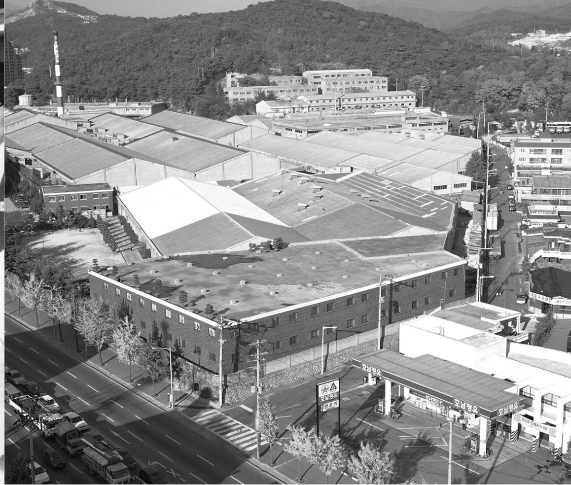
화재로 소실된 동래공장을 복구하기 위해 정부로부터 대출을 받은 일주는 만기가 되기도 전에 그 돈을 다 갚았다. 은행에만 넣어두어도 이득이 되었지만 돈으로 사업하지 않는 일주의 가치관은 이를 허락하지 않았다. 사진은 복구를 마친 동래공장 전경
